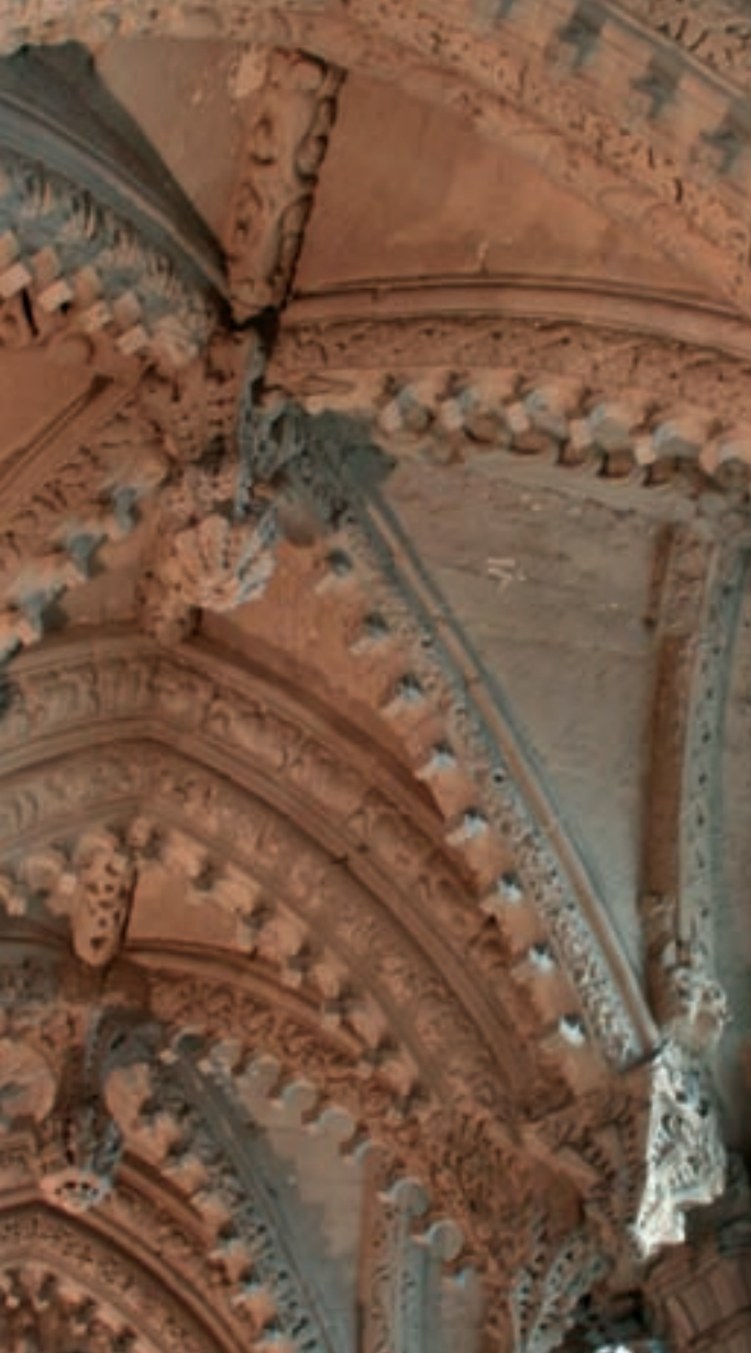
Voûtes et clefs de voûtes de la Lady Chapel Rosslyn Chapel Dessiné et construite par William Sinclair de 1440 à 1480 Roslin. Écosse. Royaume-Uni
